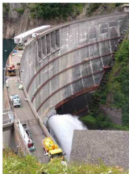
豊平峡ダム展望台からの放流状況 (耐震補強工事中)
